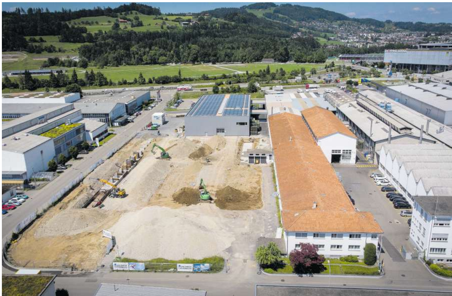
Die Arbeiten haben bereits begonnen: Auf dem Areal der Firma DGS in St.Gallen-Winkeln entsteht eine neue Fabrikhalle. Bild: Benjamin Manser
